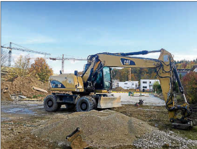
Oktober 2021 – Fundament wird gelegt
