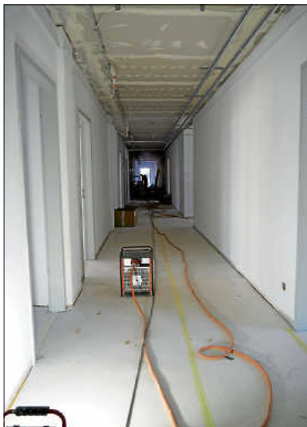
Februar 2022 – Innenausbau ist fast abgeschlossen
