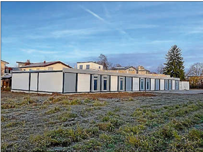
Dezember 2021 – Der Rohbau steht
