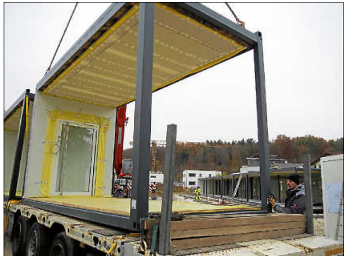
November 2021 – Module werden angeliefert und aufgebaut
