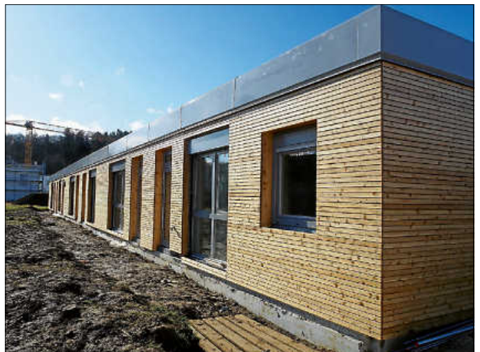
Februar 2022 – Außenfassade ist mit Holz verkleidet
