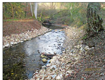
Sulzbach: Das Wehr wurde zurück gebaut
