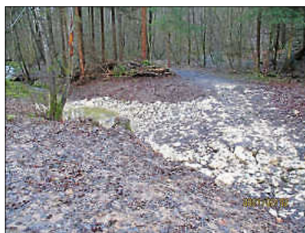
Rotbach: Die Verdolung wurde entfernt und eine Sohlgleite errichtet
