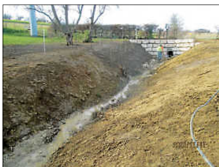
Rohrbach: Die Verdolung wurde offengelegt
