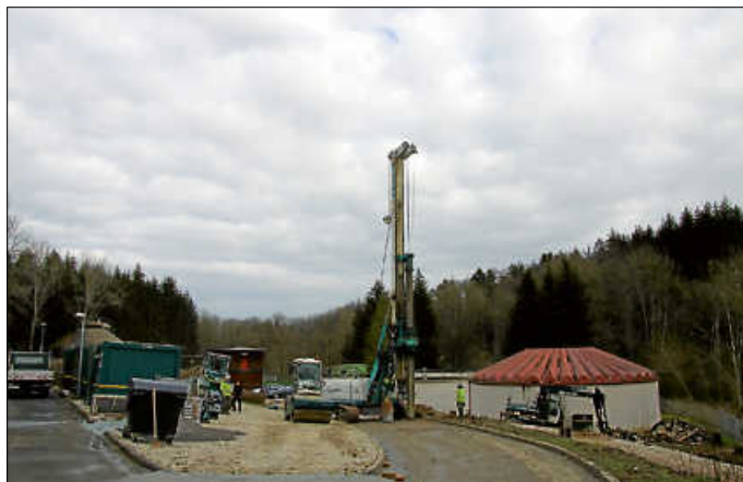
Kläranlage: Baustart für 17-Millionen-Projekt.
