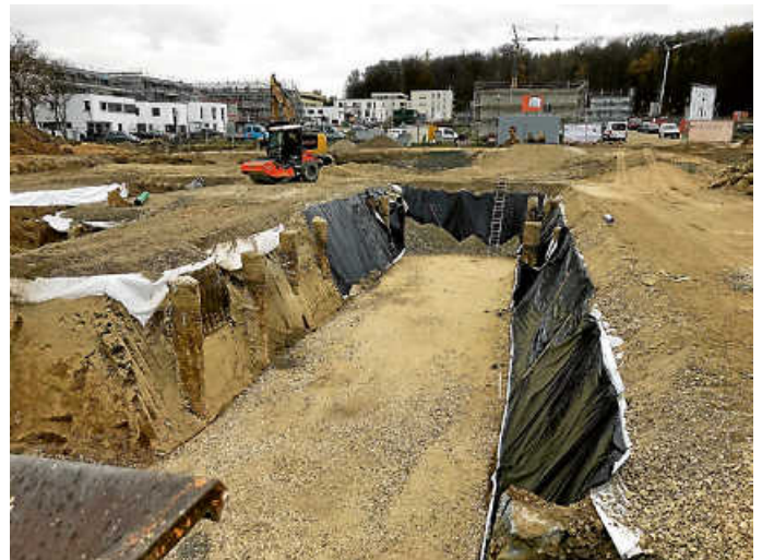
Baugrube Technikkanal mit zum Teil freigelegten Betonsäulen
