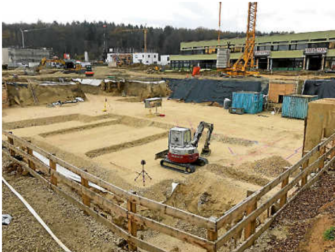
Fertiges Schotterpolster für die unterschiedlichen Höhengniveaus der Bodenplatte
