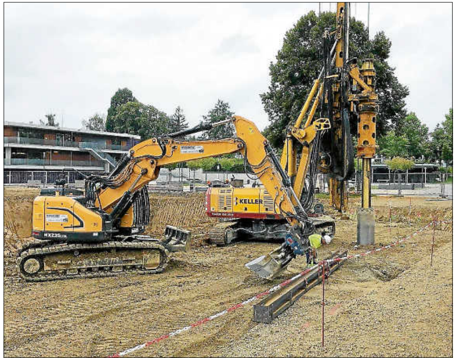
Bohrgerät auf der Baustraße beim Einbau der Stahlträger
