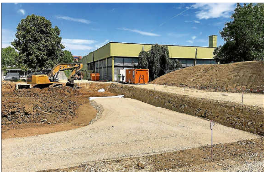
Baustraße für Bohrergerät (Verbau)
