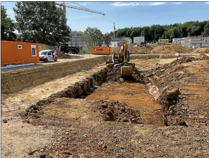
Aushub entlang der Verbauträger
