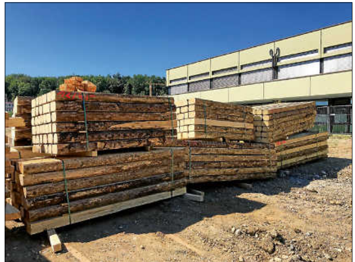
Holzbohlen für den Verbau
