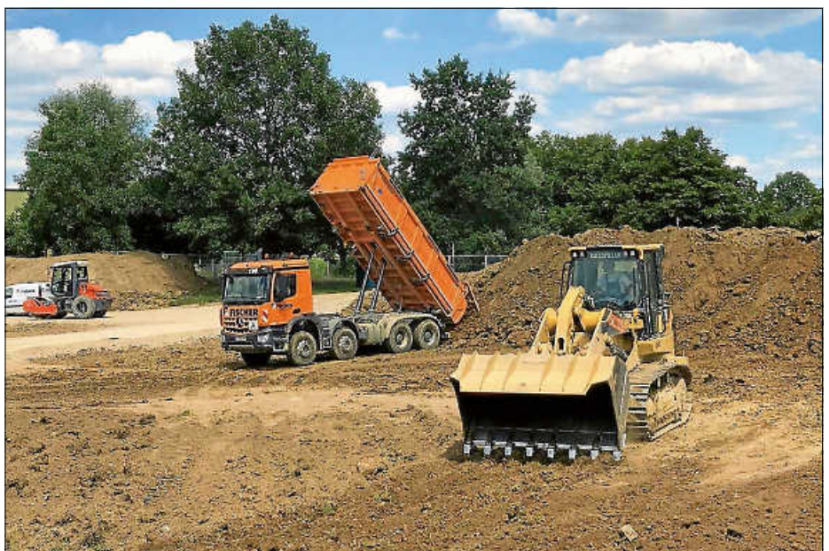
Vorbereitung der Erdarbeiten für den Verbau
