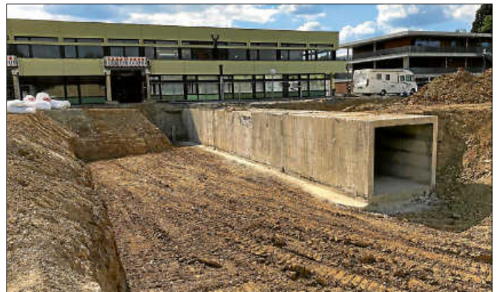
Freigelegter Technikkanal
