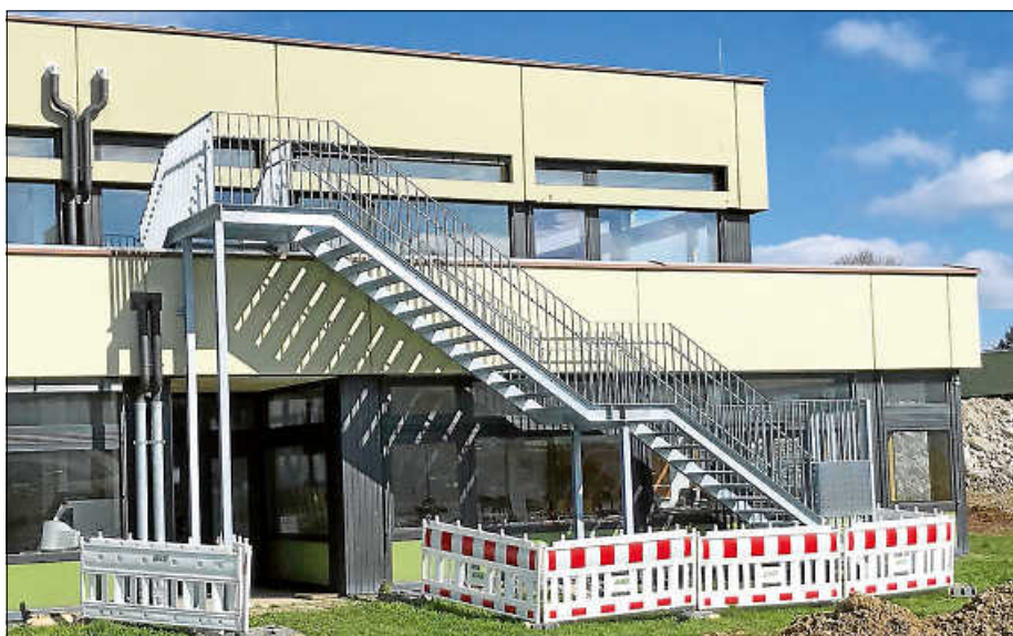
Errichtung Fluchttreppe FSS
