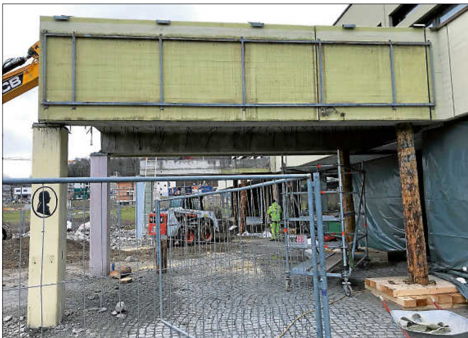
Abbruch Verbindungsdächer zur FSS
