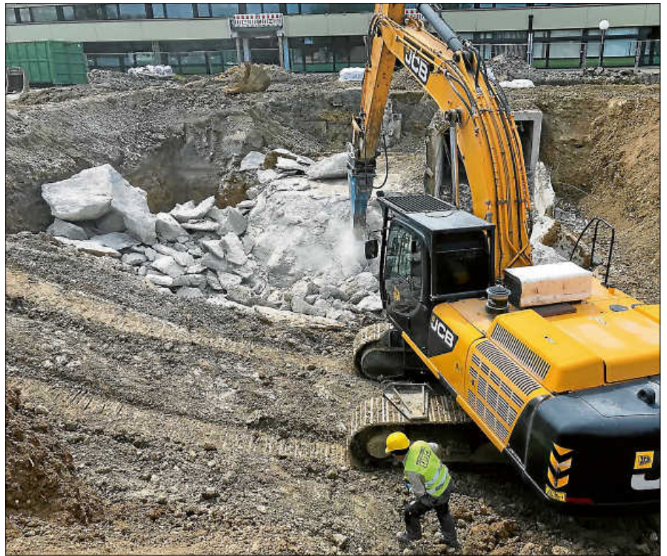
Abbruch der mächtigen Fundation
