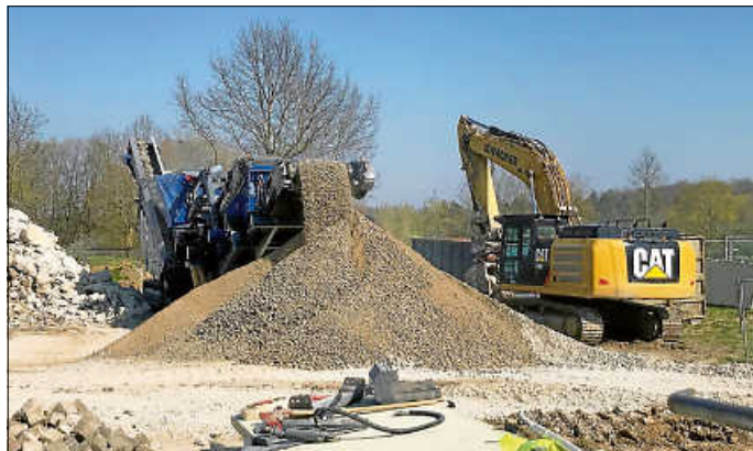
Herstellung Recyclingmaterial auf der Baustelle
