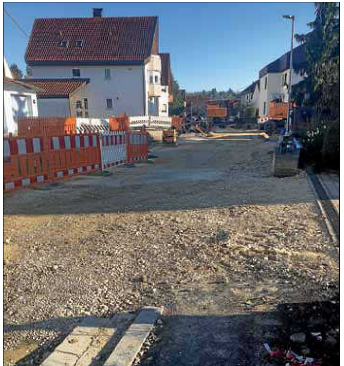
Derzeit laufen die Vorbereitungen für das Aufbringen des Fahrbahnbelags
