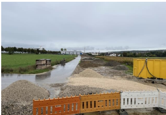
Der Abschnitt zwischen TKE Werksgelände und Neuhausen a. d. F. wird bereits für den Streckenbau geräumt
