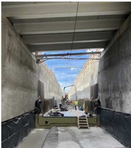
Erste Tunnelsohle direkt unter der provisorischen Werkzufahrt ist fertiggestellt
