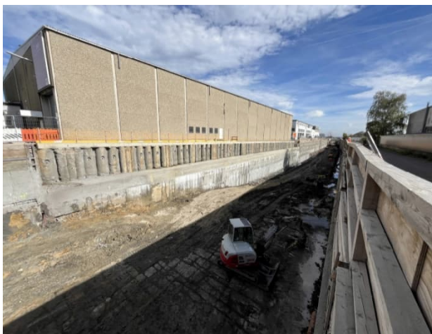
Östlich der Bahnhofstraße ist der Baugrubenaushub in den letzten Zügen. Auf dem Bild ist der spätere Bahnsteigbereich zu sehen.
