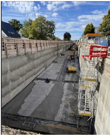
Blickrichtung Westen (Alemannenstr.) mit Herstellung der Sauberkeitsschicht der neuen Bauwerkssohle
