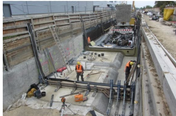
Schal- und Bewehrungsarbeiten im Bereich Block N14
