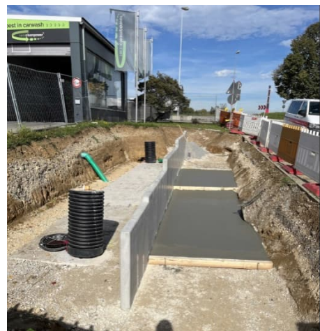
Unmittelbar vor dem Kreisverkehr in der Bahnhofstraße entstehen linker Hand eine neue Bushaltestelle und ein kleines Regenrückhaltebecken.
