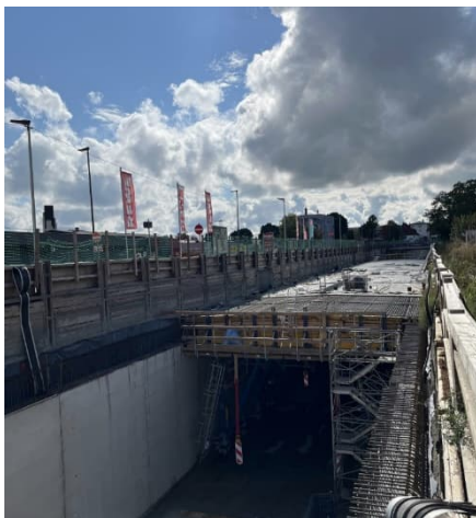
Der Tunnelbau entlang der Karlstraße wandert in Richtung Osten
