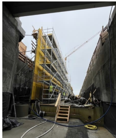
Der Betonbau der neuen Hebeanlage wächst weiter in die Höhe
