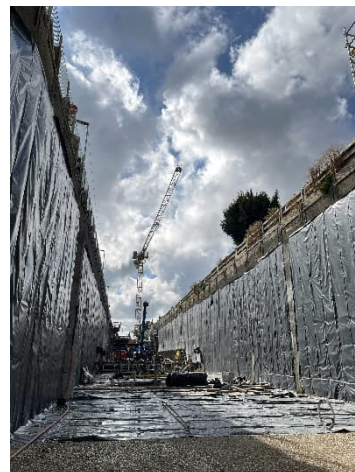
Die Filterschicht wandert der Tunnelsohle voraus
