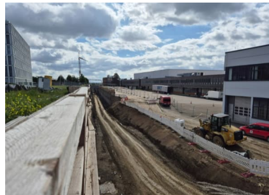
Baugrube im Westen des TKE Werksgeländes
