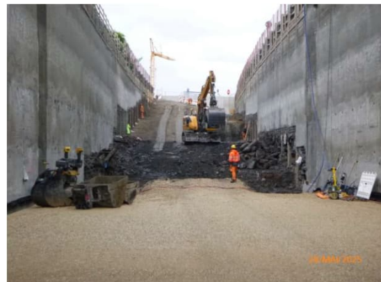
Die provisorische Rampe an der Nürtinger Straße wird abgetragen
