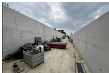
Fertiggestellte Blöcke des Trogbauwerks
