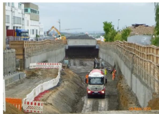
Im Hintergrund: Der Deckel in der Mercedesstraße wird bereits für den Durchstich untergraben
