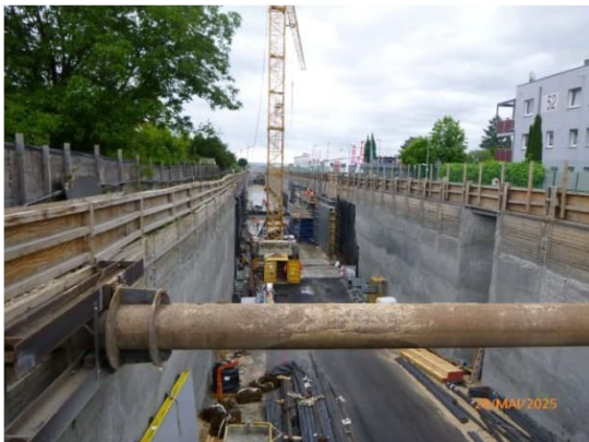
Der Betonbau entlang der Karlstraße hat begonnen und wandert in Richtung Osten
