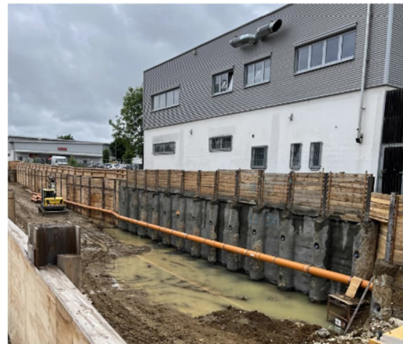
Neuer Regenwasserkanal für den Köller
