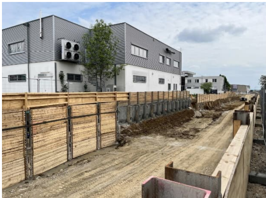
Im Westen (Alemannenstr.) wächst die Baugrube weiter
