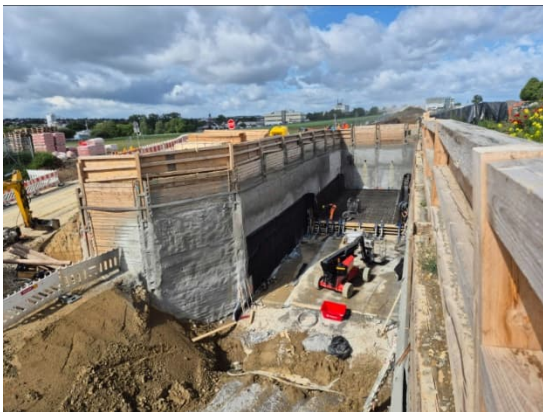
Am westlichen Ende des TKE-Werksgeländes hat der Betonbau begonnen
