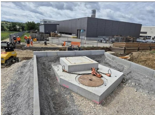
Neuer Düker unter der Streckenrampe im Osten
