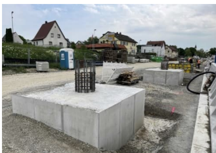
Fundamente für das neue, große Bahnsteigdach
