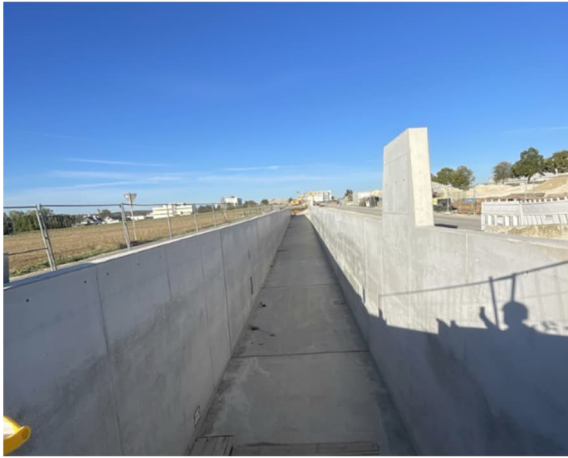
Das Trogbauwerk in Richtung Westen ist fertiggestellt
