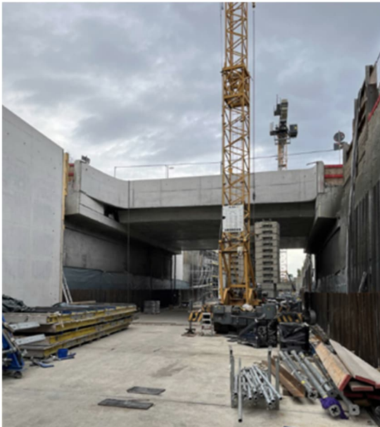
Der Deckel Bahnhofstraße Westseite: links schließt bereits die nördliche Trogwand an, rechts folgt die südliche Trogwand noch dieses Jahr
