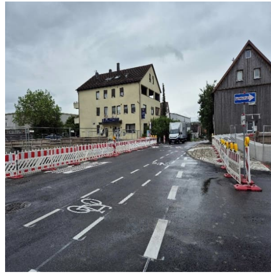
Die Bahnhofstr. hat bereits die finale Fahrbahnmarkierung erhalten
