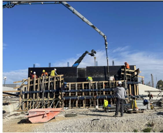
Das Widerlager Süd für die neue Feldwegebrücke wird betoniert
