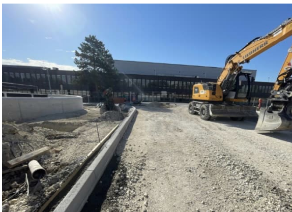
Die Werkszufahrt wird nun auf der Tunneldecke wiederhergestellt
