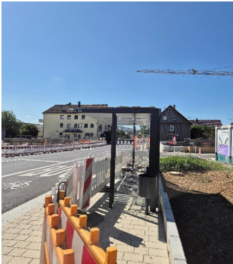
Die neue Wartehalle an der Bushaltestelle Bahnhofstraße West
