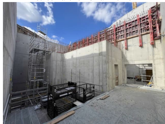
Das Treppenhaus der Regenwasserhebeanlage nimmt Gestalt an
