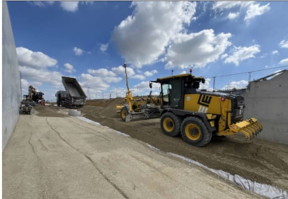
Am östlichen Ende des Rampenbauwerks in Bernhausen schließt der Unterbau der Freien Strecke nahtlos an
