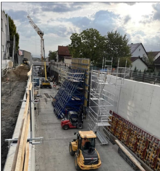
Zwischen Köller und Alemannenstr. in Blickrichtung Osten: Die letzten Wände auf der Südseite werden hergestellt
