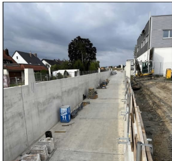
Zwischen Köller und Alemannenstr. in Blickrichtung Westen: Das Trogbauwerk ist fertiggestellt
