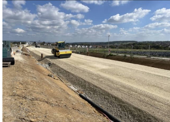
Auf dem Weg nach Sielmingen ist der Unterbau fast fertiggestellt und bald bereit für den Gleisschotter
