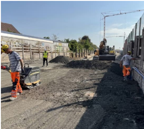
Auf dem neuen Tunnel wird die Abdichtung und danach bereits die Überschüttung für den Straßen- und Leitungsbau eingebaut
