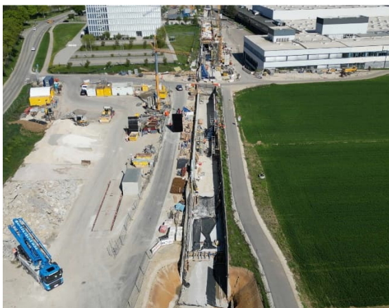
Das Trogbauwerk der westlichen Rampe entsteht am TKE-Werksgebiet
