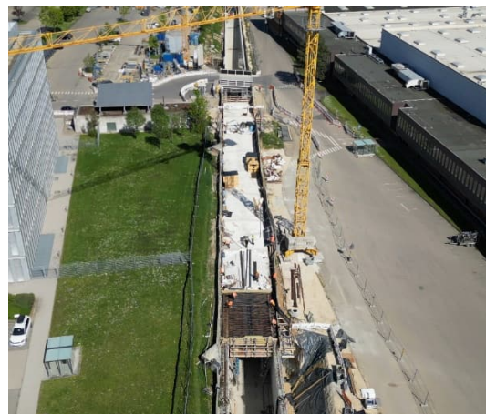
Der Tunnel auf dem TKE-Werksgebiet wächst von Ost nach West in die Länge
