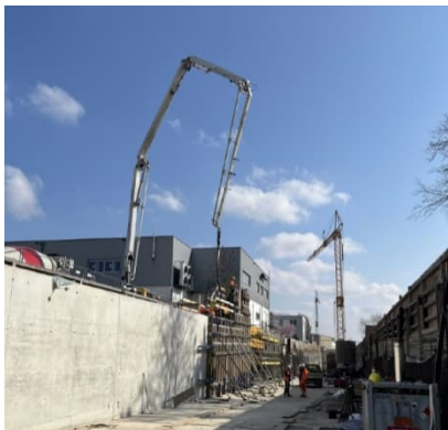
Zwischen Köller und Alemannenstr. mit Blickrichtung Osten: Wände und Sohlen werden betoniert
