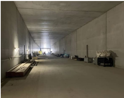
Licht am Ende des Tunnels i. R. Westen
