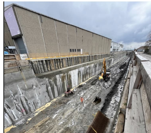
Blick in die Baugrube der zukünftigen Haltestelle Sielmingen i. R. Osten
