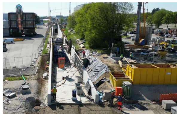
Das Trogbauwerk der östlichen Rampe ist fertiggestellt
