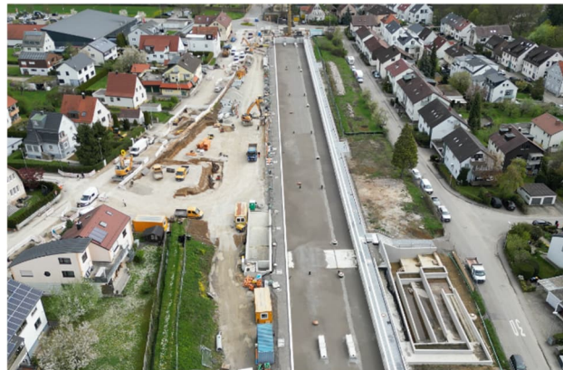
Im Umfeld des zukünftigen Bahnhofs zwischen Bahnhofstr. und Max-Eyth-Straße wird kräftig gebaut
