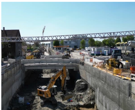
Der Deckel unter der Bahnhofstraße ist bereits freigegeben – in Kürze kann mit den Vorbereitungen für den Haltestellenbau begonnen werden
