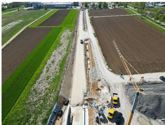
Die Freie Strecke zwischen TKE-Werksgelände und Neuhausen a. d. F. ist in Arbeit. Rechter Hand sind die Rigolenspeicher und die Baustraße zu erkennen
