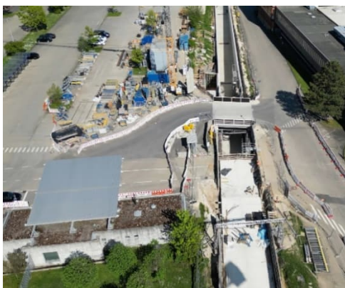
Im Bereich der TKE-Werkszufahrt wird die Regenwasserhebeanlage und das Tunnelportal erstellt
