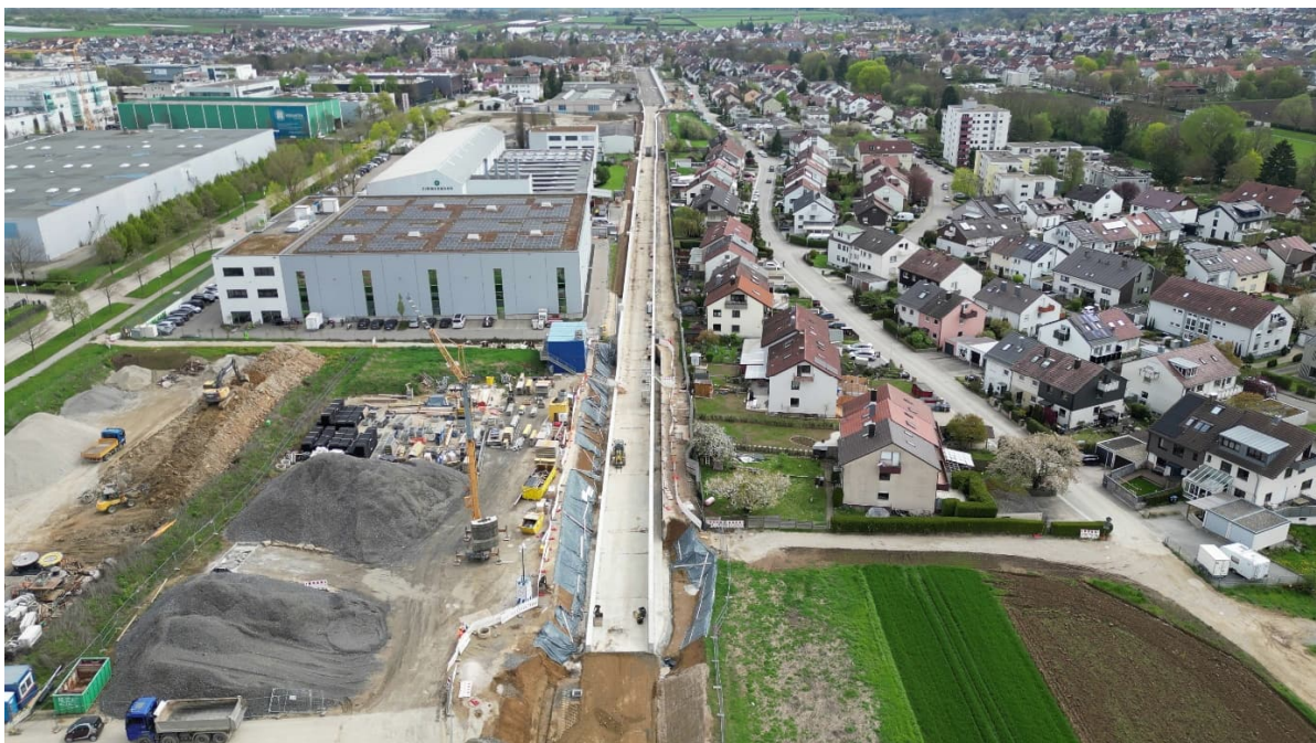
Das Bauwerk in Neuhausen a. d. F. ist fertiggestellt; Im Hintergrund ist der zukünftige Bahnhof erkennbar
