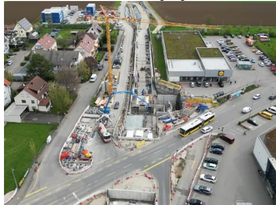
Die Regenwasserhebeanlage wächst in die Höhe
