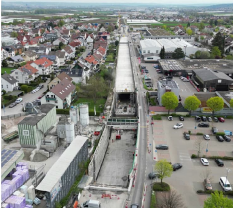
Blick i. R. Osten: Das letzte Stück Tunnel wird gebaut
