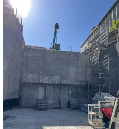
Die Abschlusswand des bestehenden S-Bahn-Tunnels ist für den Anschluss freigelegt worden
