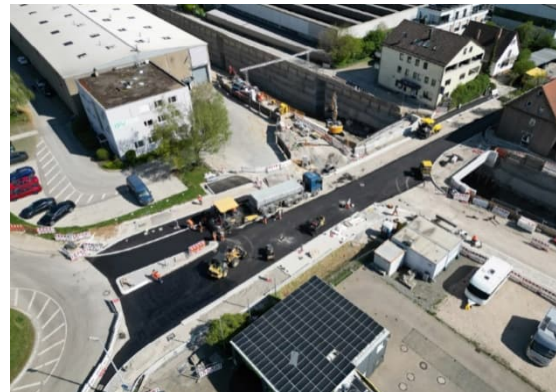
Die Bahnhofstraße wird neu asphaltiert
