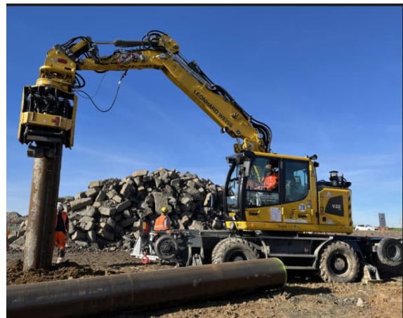
Herstellung der Rammrohrgründungen auf der freien Strecke für die Gründung der Fahrleitungsmasten
