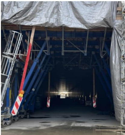
Licht am Ende des Tunnels unter der neuen Karlstraße
