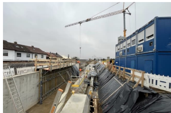
Am westlichen Ortseingang von Neuhausen a. d. F. werden bis Ende März alle Wände fertiggestellt sein.
