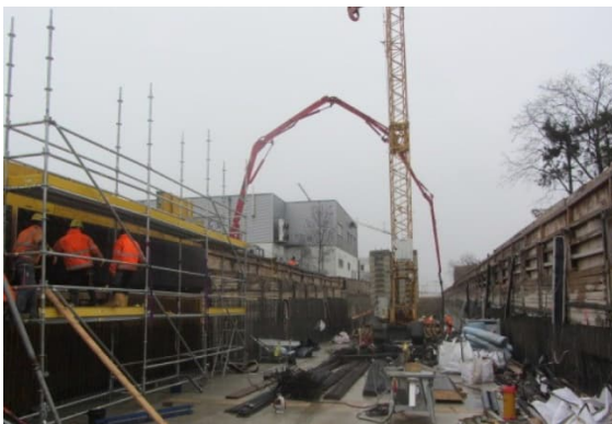
Zwischen Köller und Alemannenstr. mit Blickrichtung Osten: Wände und Sohlen werden betoniert
