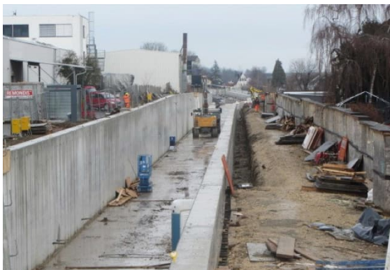
Auf der Nord- und Südseite des Trogbauwerks wird der temporäre Baugrubenverbau oberflächennah entfernt
