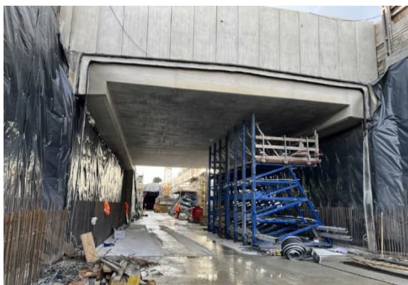
Oben verläuft die Nürtinger Straße, im Hintergrund kommt der Tunnelmund von Westen immer näher
