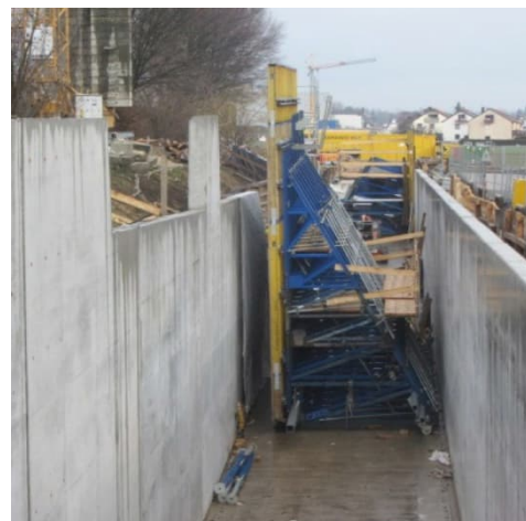
Die ersten 150m Trogwände i. R. Osten sind fertiggestellt
