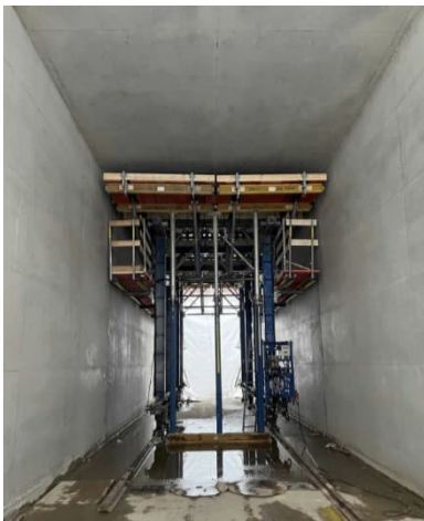
Deckenschalwagen im ersten Tunnelblock im Einsatz
