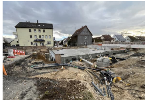
Deckel Bahnhofstraße Nordseite: Die Kabel, Kanäle und Leitungen werden neu geordnet
