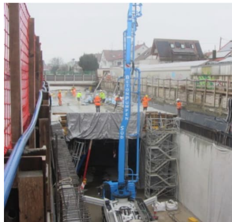
Der 26. Deckenabschnitt des Tunnels wird betoniert
